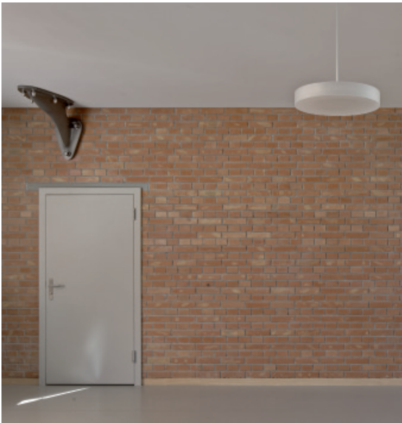
Erdbebensicherheitsmassnahmen im Westtrakt
